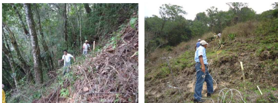
Figura 3. Abertura de la brecha, que define la trayectoria de la tubería de conducción
