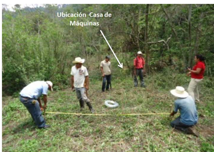
Figura 4. Trazado de dimensiones para Casa de Máquinas
